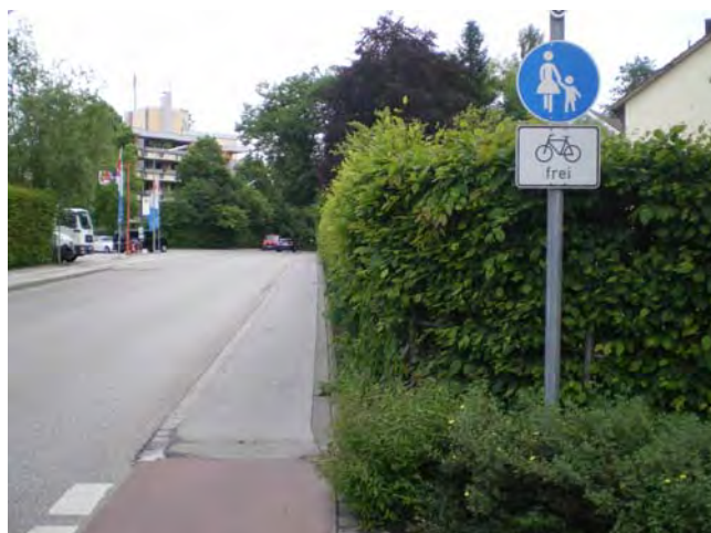
Bild 40: Niveaugleicher schmaler Gehweg in der Ebersberger Straße
