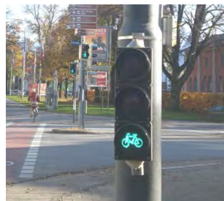
Signalanlage mit Radverkehrssignal
