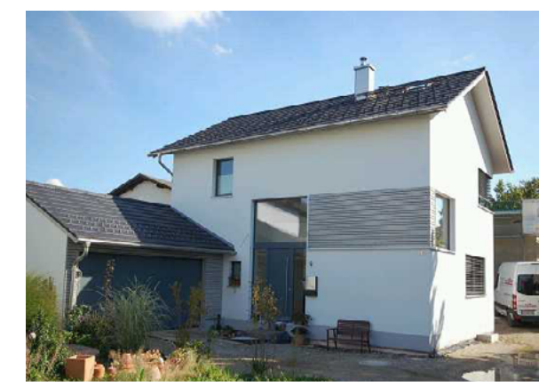
Fam. Bonleitner , Einfamilienhaus, ID 2604 Mitterfeldstr. 14a, 83043 Bad Aibling Öffnungszeiten: 10 – 12 Uhr
